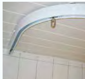
90°-Bogen an Holzdecke
